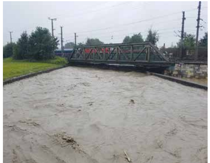
Hochwasser an der Wörgler Bahnbrücke
