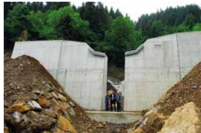
Die Verbauung des Feichtner Grabens war die größte Baustelle im heurigen Sommer.
