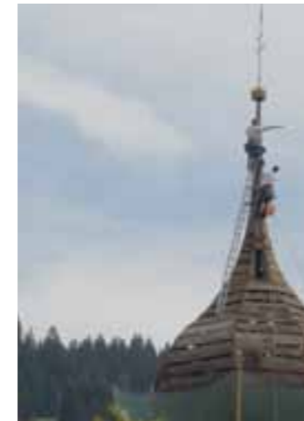
Luftige Dachdeckerarbeit auf dem Kirchturm
