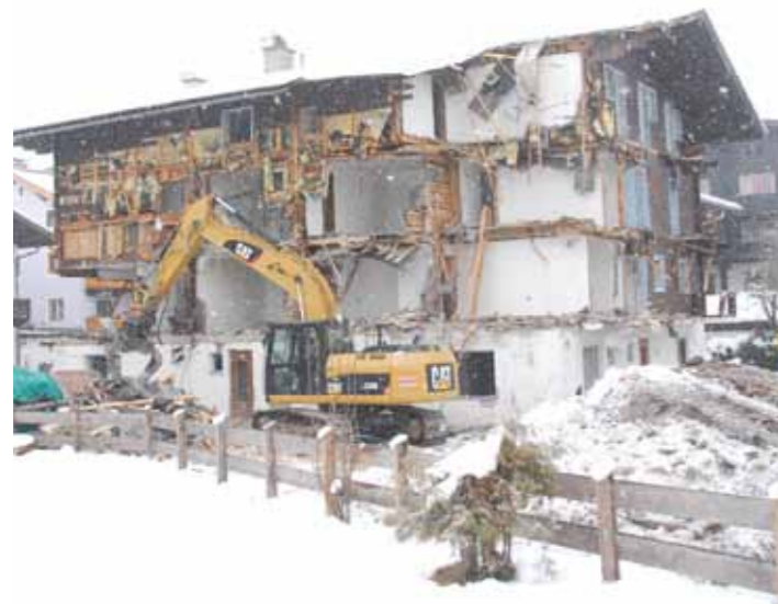
Am 21. Jänner fuhr der Bagger auf und es wurde mit dem Abriss des Klingler-Gebäudes im Dorfzentrum begonnen.
