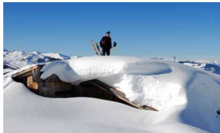
Auf der windabgewandten Seite kommt auch auf den Dächern von Almhütten ein beträchtlicher Schneestock zusammen (Brandegg, Foto: A. Sieberer)
