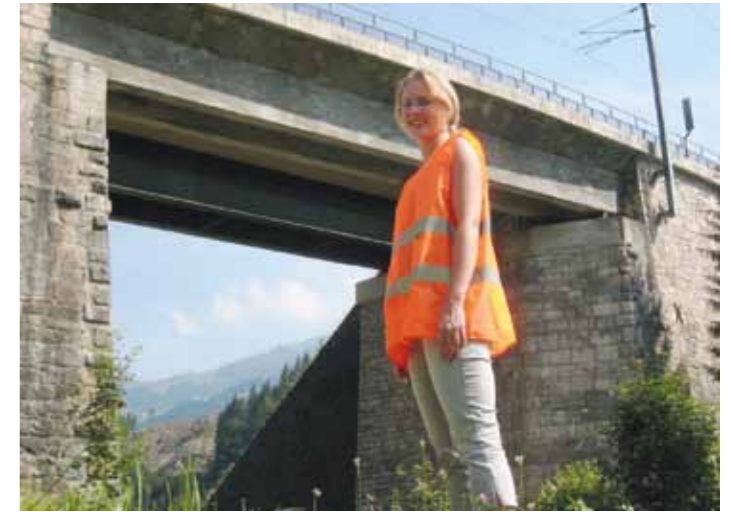
ÖBB-Baumanagerin DI Stefanie Kotter vor der „Huachn Brugg“; die alte Spannbetonbrücke wird bis Ende August erneuert.
