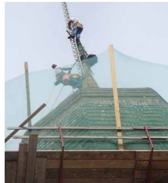
Die Renovierung des Kirchturms war seine letzte große Aufgabe.
