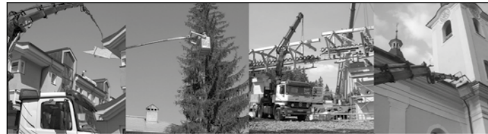
Fertigteilversetzung in eng bebautem Gebiet | Baumfäll- & Baumschnittarbeiten bis ca. 30 Meter Höhe | Liftstationsbau im unwegsamem Gelände | Universeller Einsatz des Arbeitskorbes
