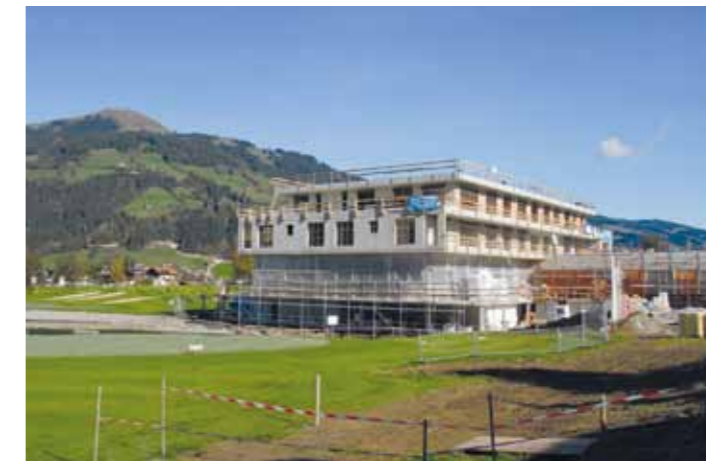
Die größte Baustelle im vergangenen Sommer: das Clubgebäude beim neuen Golfplatz
