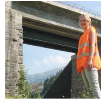
Die Bahnbrücke in der Windau wurde saniert.
