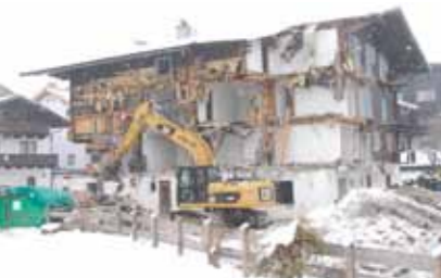
Abriss des Klingler-Hauses
