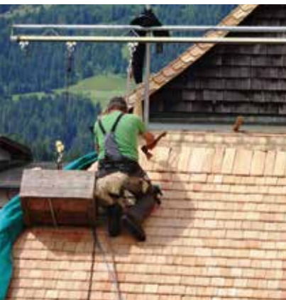
Das Kirchendach wurde im Frühjahr mit neuen Schindeln eingedeckt.
