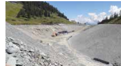
Die Großbaustelle „Kreuzjöchlse“
