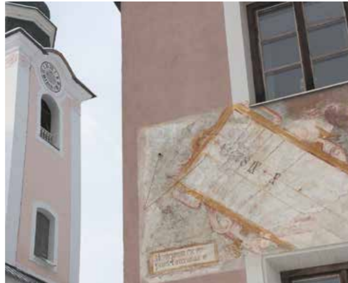
Früher konnten auch Turmuhren nur mit der Sonnenuhr eingestellt werden (Sonnenuhr am Brixner Pfarrhof).
