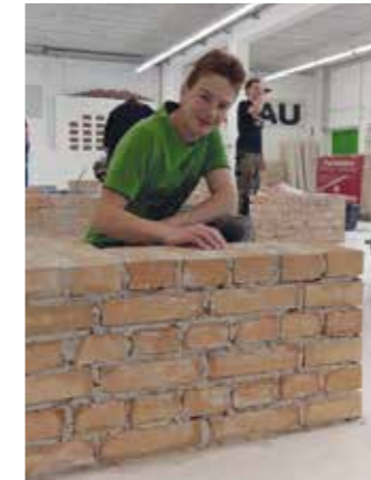
Michael mit seinem fertigen Mauerwerk
