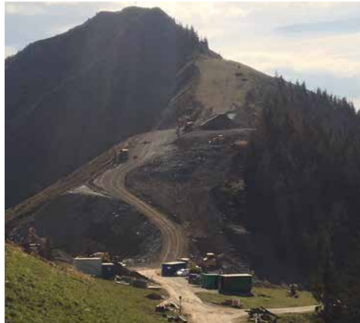
Das schöne Wetter bis weit in den Oktober hinein kam auch den Bergbahnen sehr gelegen, die vor dem Beginn der Wintersaison noch einiges zu erledigen haben. So wird derzeit der Buckel des „Höhninger“ abgeschoben und flacher gestaltet (eine Vorarbeit für den neuen Fleidinglift). Gleichzeitig wird der Laubkogellift in verkürzter Form (nur noch auf einer Seite) auf einer neuen Trasse errichtet.
