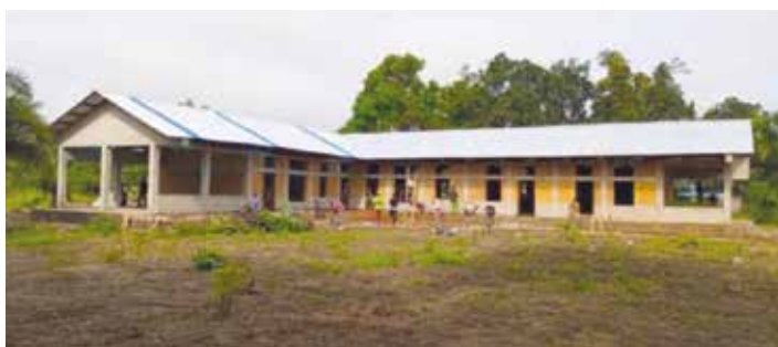
Baustand März 2023 (der rechte Gebäudeteil steht)
