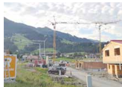
Die Bauarbeiten an der Reihenhaussiedlung Lindacker begannen im Sommer.
