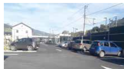
Der Park&Ride-Bereich beim Bahnhof konnte fertiggestellt werden.
