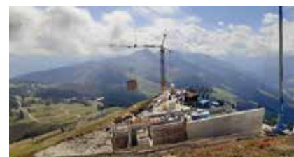
Auf dem Fleiding wurde den ganzen Sommer über gebaut.
