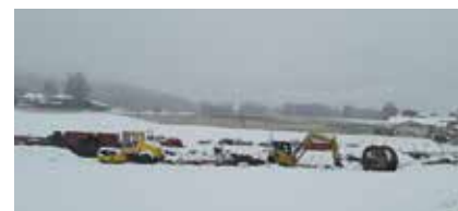
Mit den Bauarbeiten beim Siedlungsgebiet Lindacker wurde begonnen..
