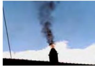
Sichtbarer Rauch bedeutet unvollständige Verbrennung, weil bei unterem Anzünden die Ausgasung des Holzes zu rasch erfolgt und dafür die Luftzufuhr nicht ausreichen kann. Folge: Energieverlust und Umweltverschmutzung. ABER: auch zu viel Luft - ab der
