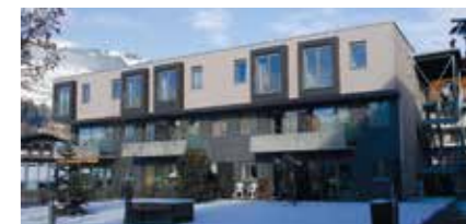
Die neuen Einheiten beim Betreuten Wohnen wurden fertiggestellt.
