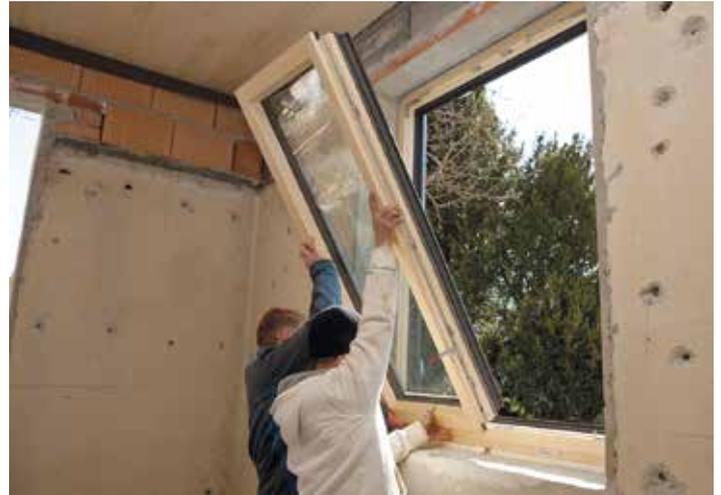
*Der Fenstertausch wird idealerweise gemeinsam mit der Fassadendämmung durchgeführt – dadurch können die Anschlüsse optimal und wärmebrückenfrei ausgeführt werden (Foto: Energieagentur Tirol).*
